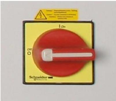
**5.2** An der Tür außen liegenden Anschaltknopf in Position „ON“ drehen
